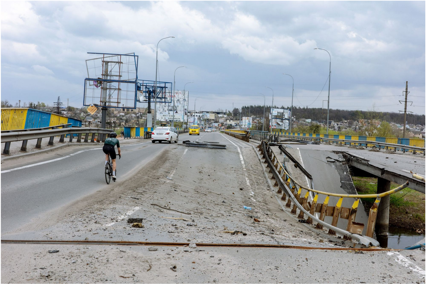
Eine Velotour in die Vororte von Kiew: Eine zerstörte Brücke im Mai 2022. Lesha Berezovski
